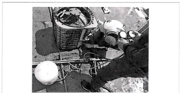
Calibración de la presión del agua que circula por los ductos
