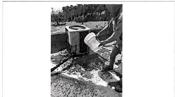
Limpieza con agua de los compresores
